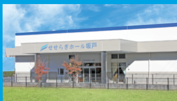
せせらぎホール 坂戸 埼玉県坂戸市石井2330
